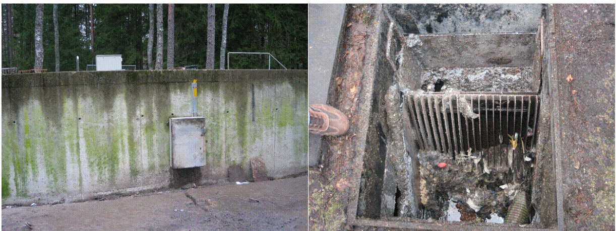
Joonis 4.8 Tammemäe purgimissõlme välisvaade ja võresõlm
