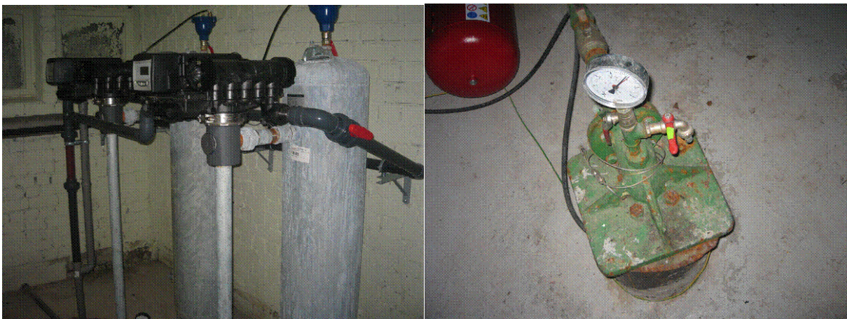
Joonis 4.20 Jälgimäe küla pumpla vee puhastusseadmed ja puurkaevu päis
