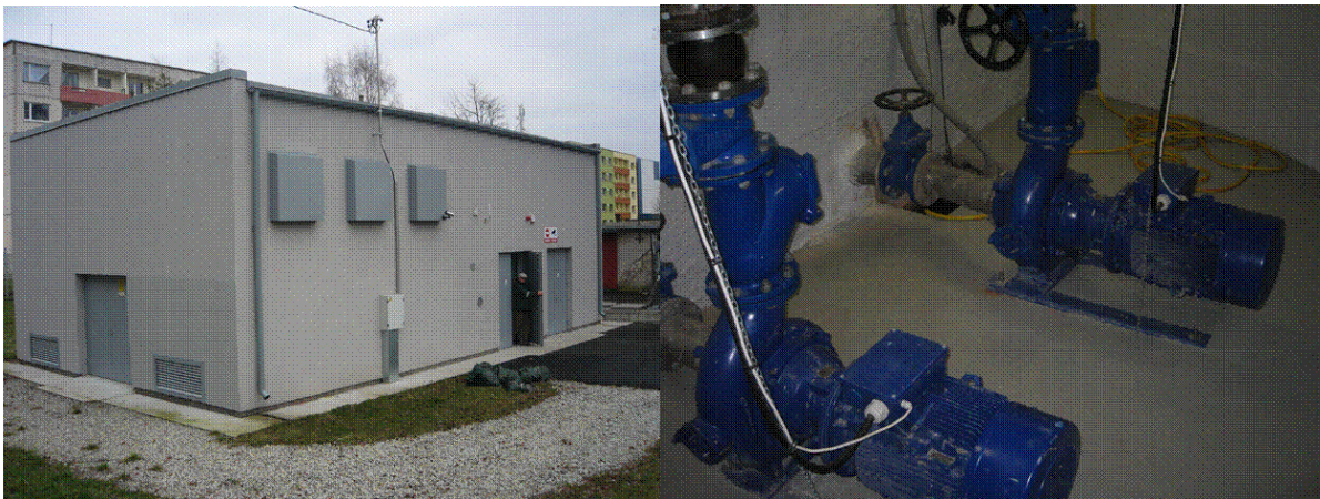
Joonis 4.7 Saku aleviku Kannikese reoveepumpla välis- ja sisevaade
