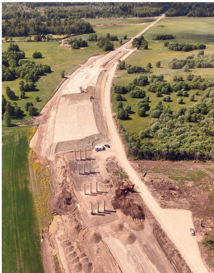
Saku-Tõdva viadukti valatud postid – 24.05.24
