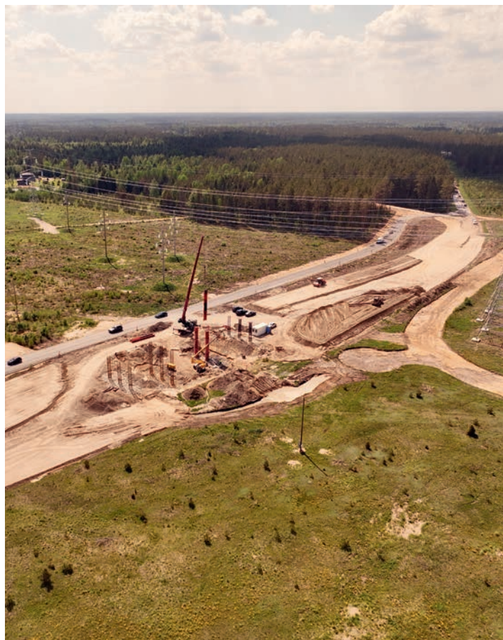
Tõdva-Hageri viadukti postide rajamine – 24.05.24
