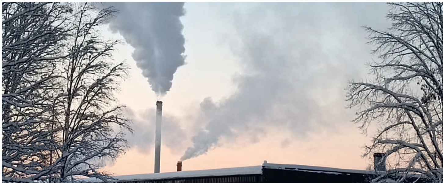
Tehnika katlamaja korsten.
