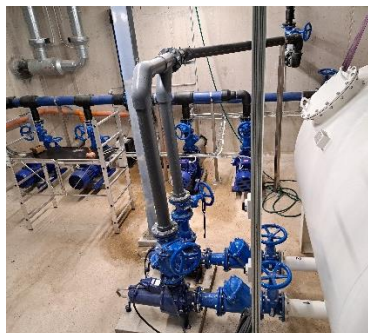
Fotod 4.11. Roobuka vaakumpumpla ja purgla
