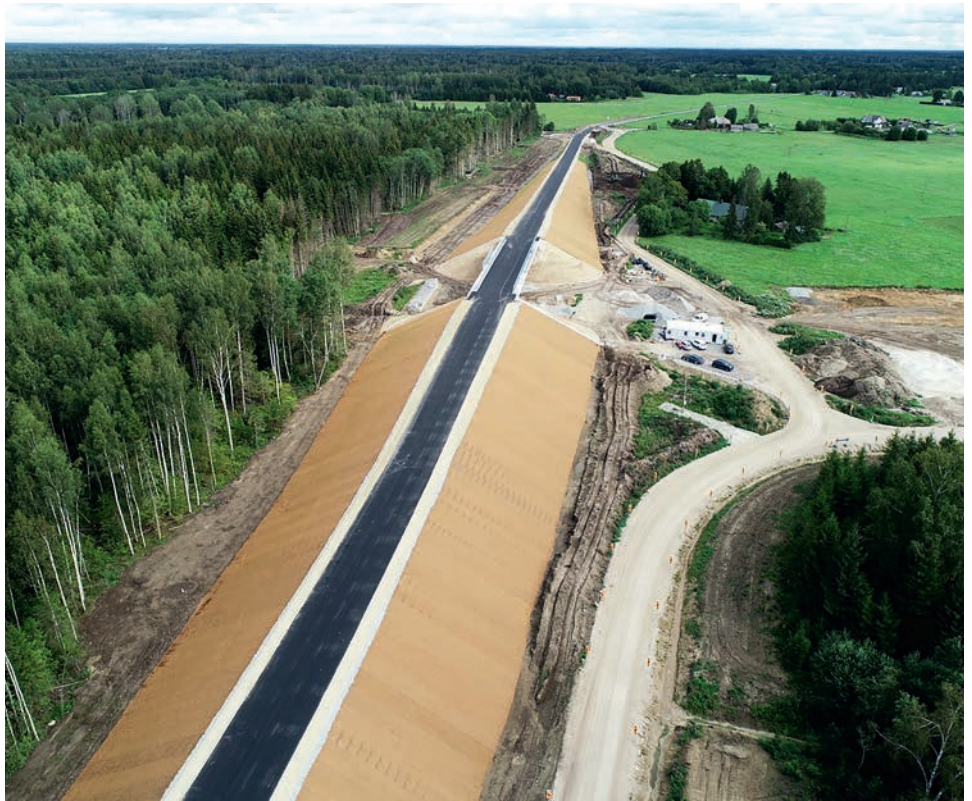
Saku Sõnumite ilmumise ajaks on autoliiklus suunatud juba Tagadi-Kurtna viaduktile, mis on joonitud ja varustatud pörkepiiretega.
