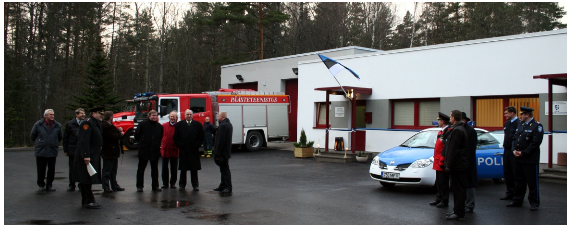
Kõrgete külaliste osavõtul novembris 2006 pidulikult avatud Saku Operatiivteenistuste Keskus Tammemäel koondas ühe katuse alla kiirabi, politsei ja päästeteenistuse. Foto: EE
