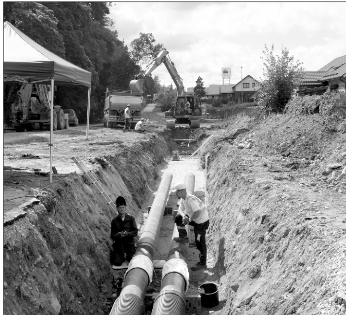
Saku suurte torutööde järg on jõudnud Juubelitamme tee, Teaduse ja Tiigi tänav (pildil) piirkonda. Korraga paigaldatakse vee-, kanalisatsiooni- ja kaugküttetorustikke. Foto: ☺☺
