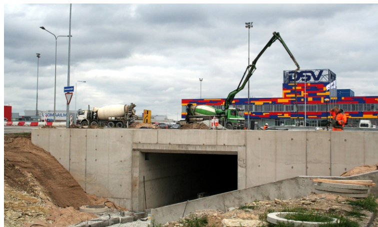
Liiklussõlme ehitustööde raames on kaubanduskeskuste piirkonnas valmimas ka jalakäijatele mõeldud maanteealune tunnel. Foto: ES
