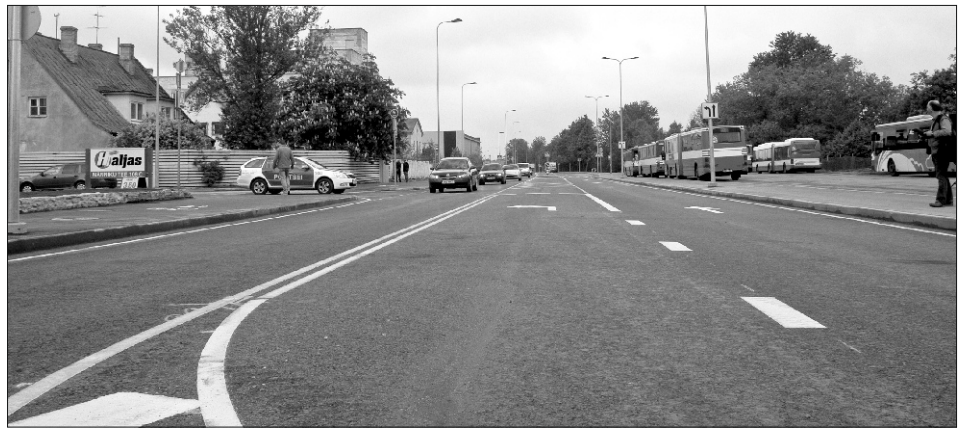
10 kuud kestnud Männiku tee remont on lõpuks läbi ja sissesõit Tallinnasse sile. Fotod: EE
