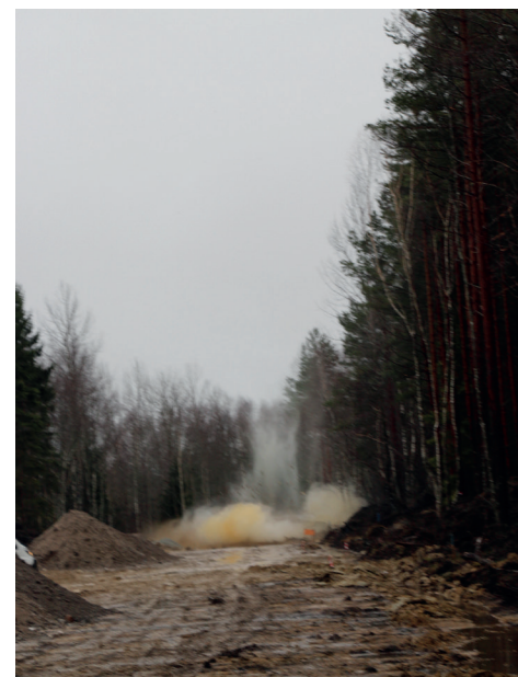
Lõhkamised toimuvad päeval kell 12–15. Fotod: SS
